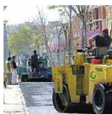
Obras en el carril de Pino Montano.
