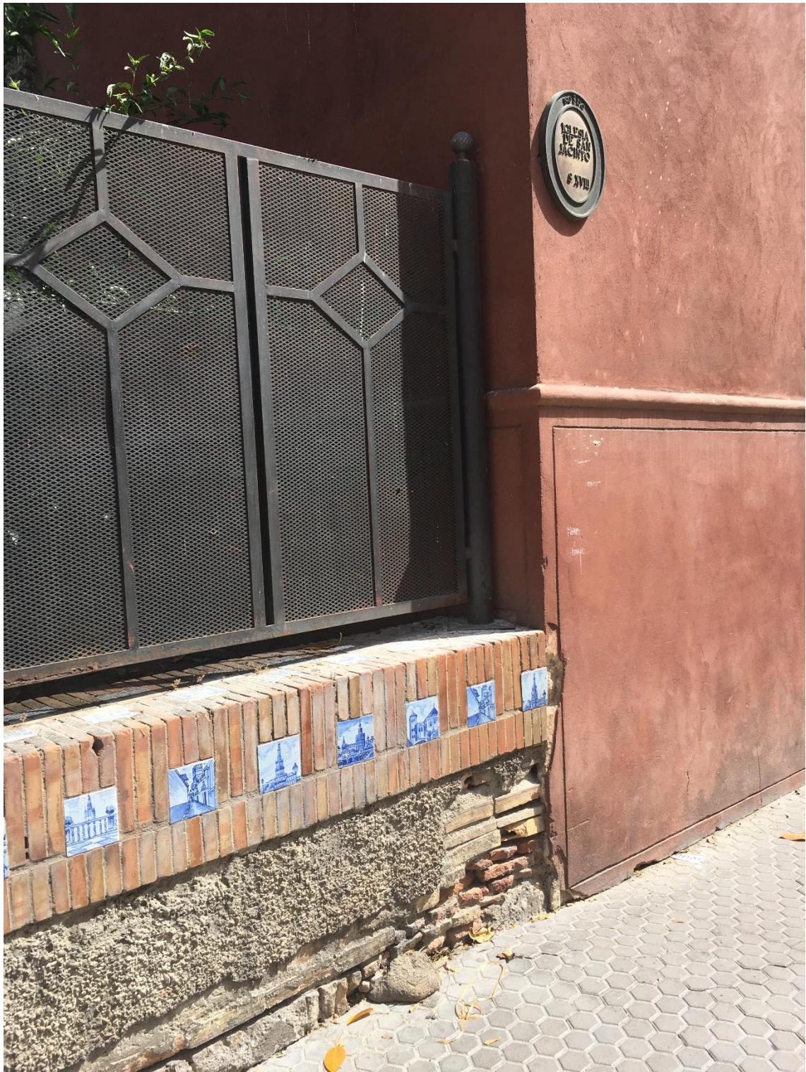
Ilustración 4.- Encuentro del muro de contención del relleno del compás del templo con el muro de la fachada principal de la iglesia
