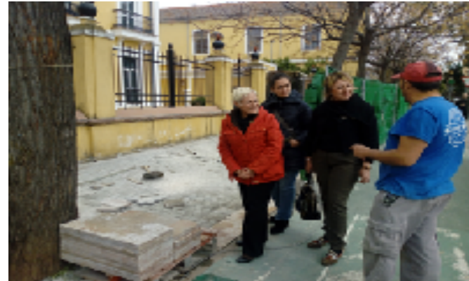
La Delegada del Distrito Nervión supervisando las obras
