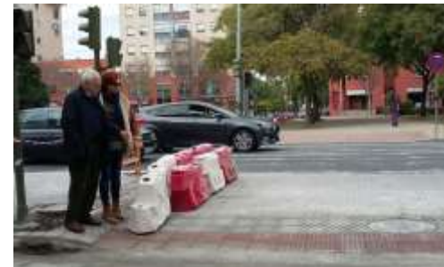
Obras de adecuación de un paso de peatones enmarcadas dentro del plan de actuación
