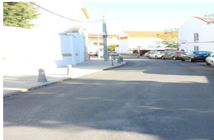
Una de las calles de Ciudad Jardín con la nueva pavimentación
