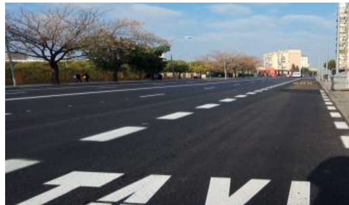
Vista del renovado pavimento del carril bus de la calle Ada
