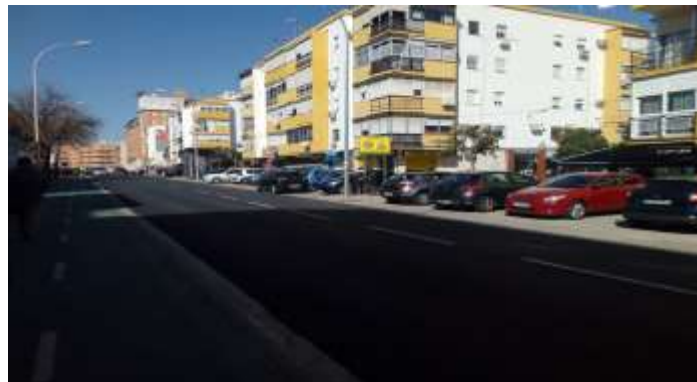
Vista del nuevo aspecto de la calle
