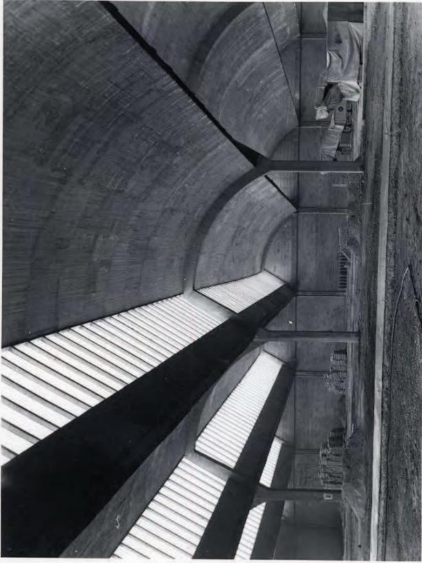
Según información obtenida del citado Archivo de Carlos Fernández Casado, tras su construcción, se detectan daños en los pórticos centrales, mostrando grietas al lado inferior de las vigas que deben eliminarse. De ahí probablemente los refuerzos metálicos que aparecen actualmente en todos los pilares del pórtico central y que debieron ser realizados por el profesor Casado.<sup>1</sup>
