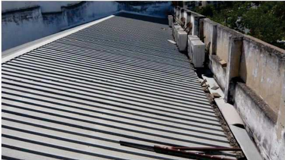
magen de la cubierta inclinada de chapa sobre la primera crujía de calle Muñoz y León 5, (puede observarse que no es cubierta transitable y el material de cubrición es contemporáneo).
