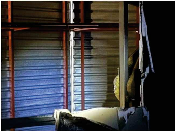
Imagen interior de la estructura de cerchas metálicas IPE que sustentan chapa galvanizada correspondiente a la cubrición de la 2ª y 3ª crujía de Muñoz y León nº 5. Obra ejecutada con a finales de la década de los años 90.
