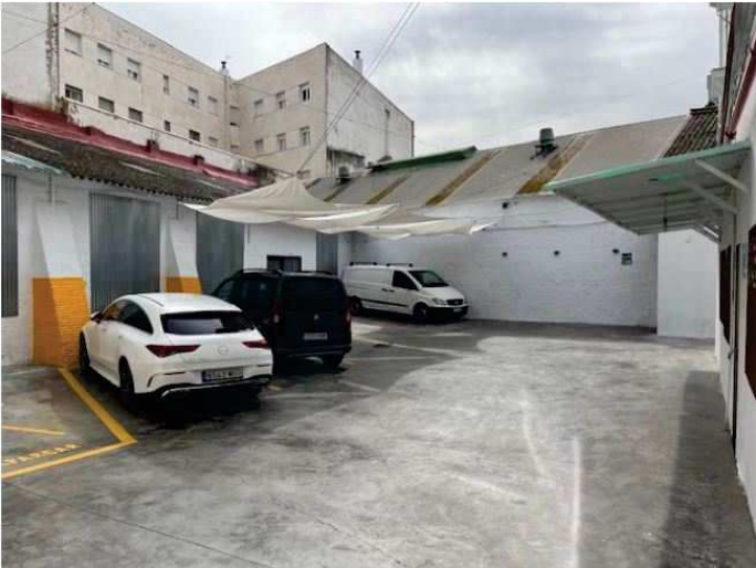
Imagen de uno de los patios traseros donde se observan las construcciones auxiliares cubiertas por chapa de fibrocemento.
