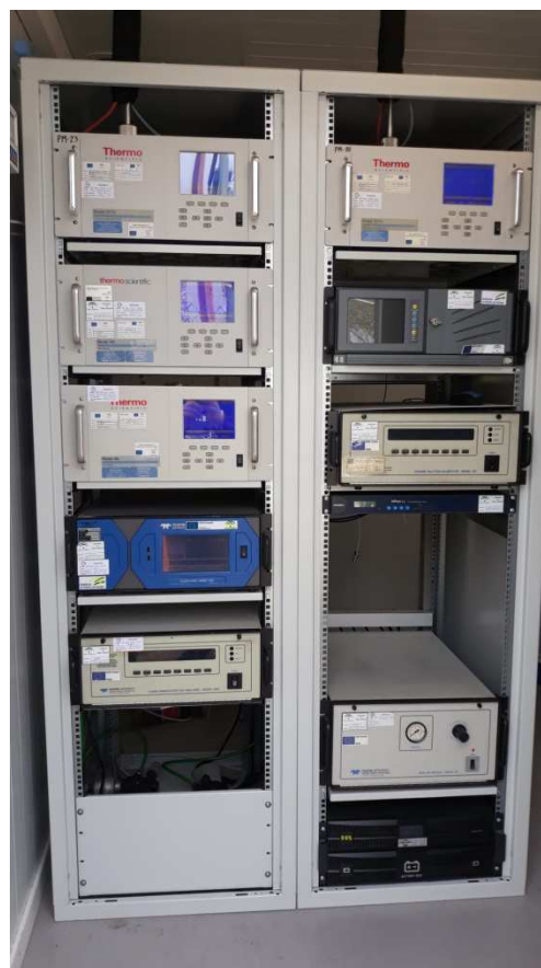
Interior Estación Bermejales
