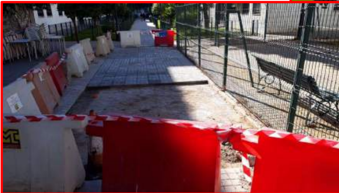
Conservación de acerado C/ Binefar
