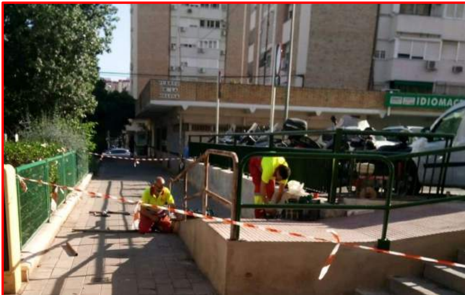
Arreglos y pintado de barandillas rampa de acceso C/ Puerto de la Molina
