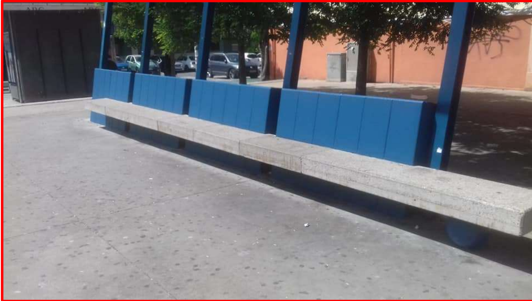
Pintado de bancos Plaza Real Patronato de Casas Baratas
