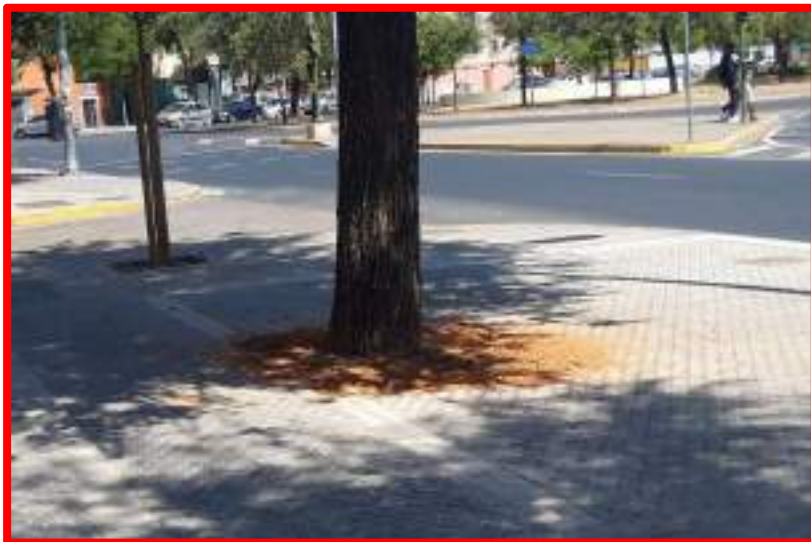
Reparación acerado y alcorques Avda. Juan XXIII
