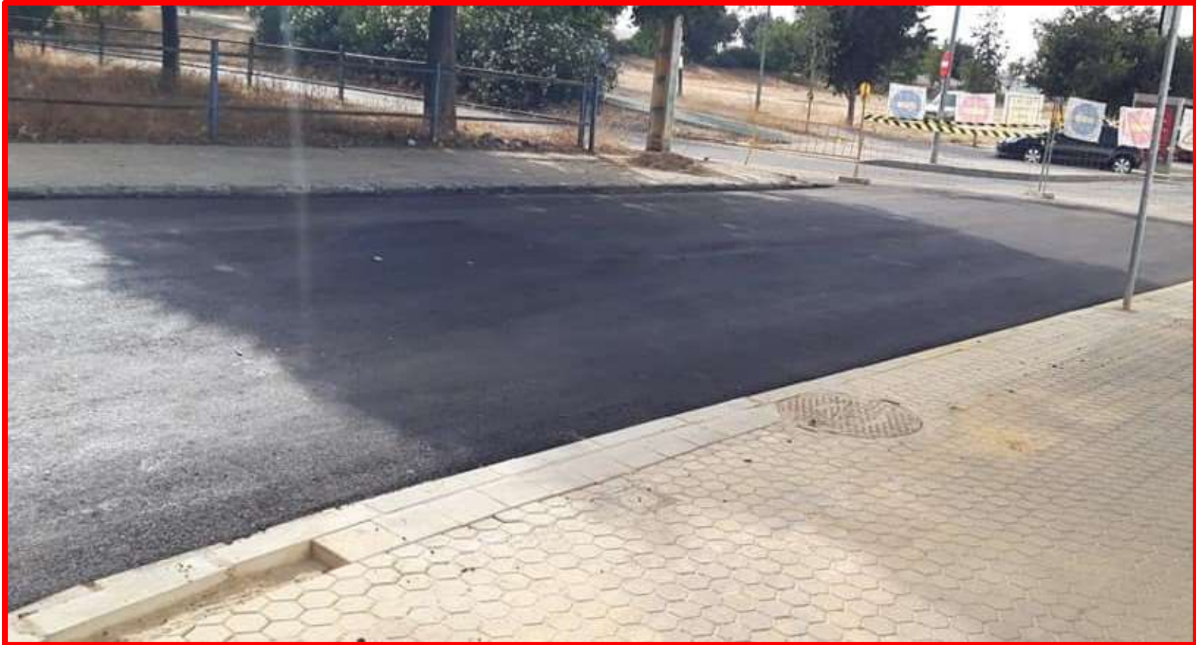
Obras canalización C/ Afecto, esquina C/ Indulgencia
