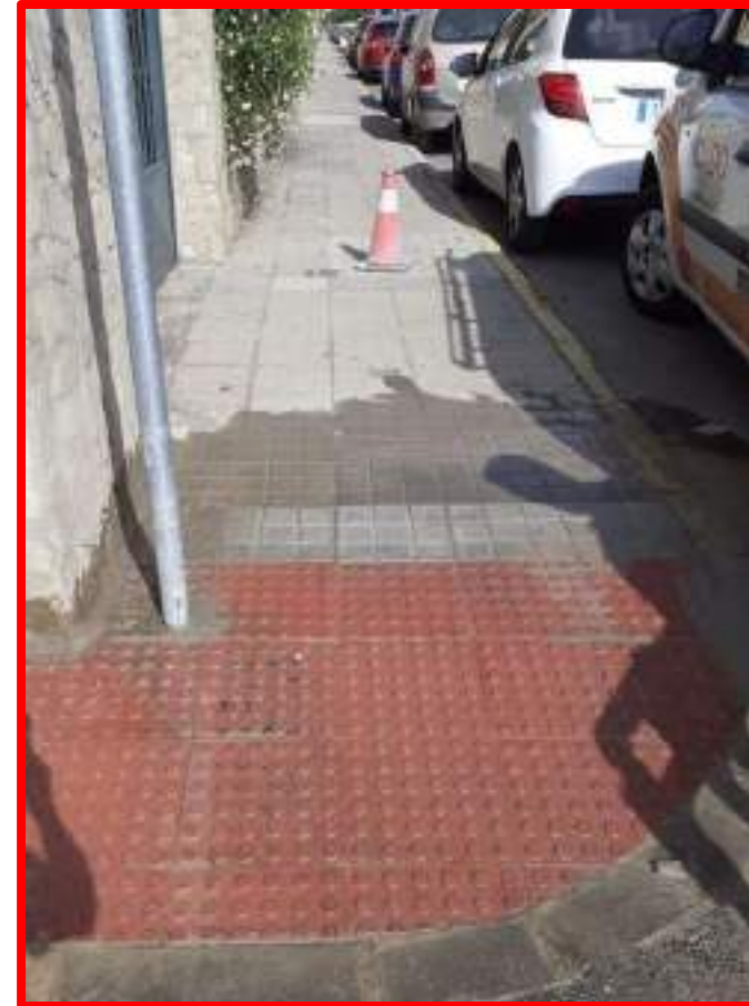
Arreglos rebaje y bordillos C/ Guadix
