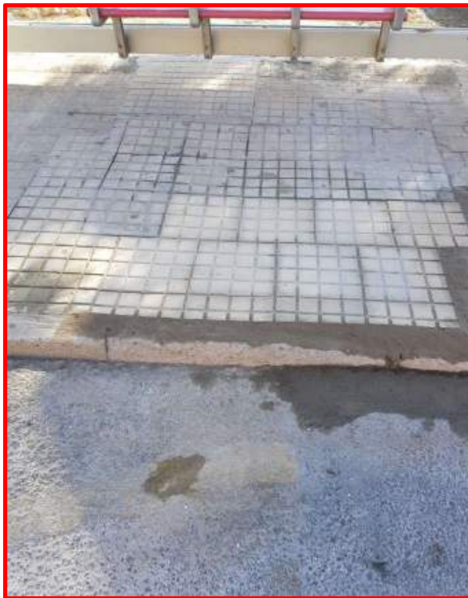
Reparación acerado junto parada Tussam C/ Honestidad, esquina C/ Comprensión
