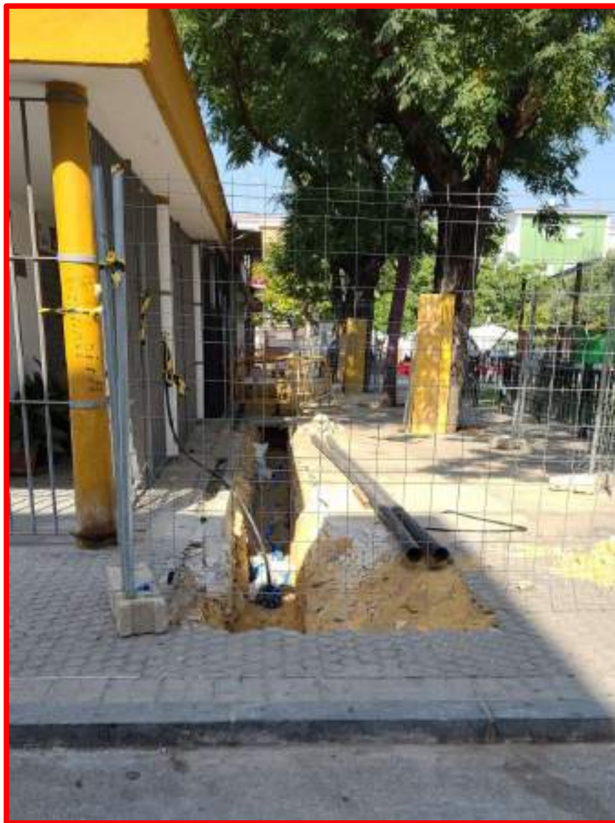
Obras Emasesa C/ Candil previas a reurbanización Plaza de La Candelaria
