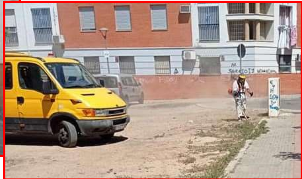
Desbroce terrenos junto Centro de Salud La Candelaria
