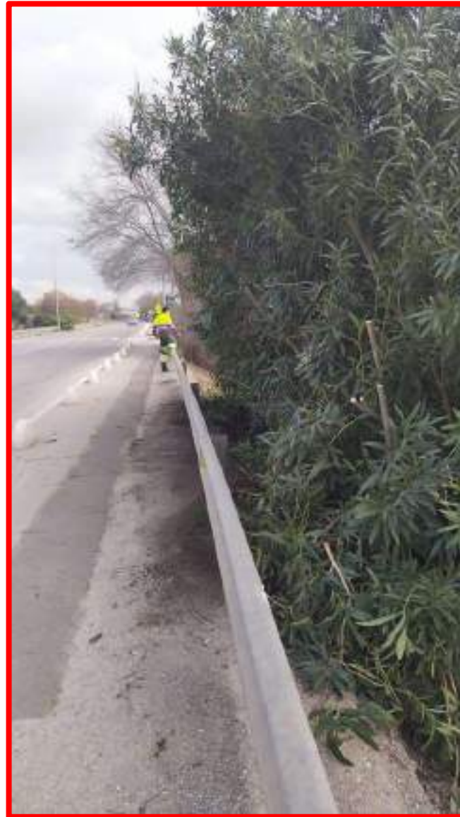
Poda de adelfas talud Ronda de Padre Pío
