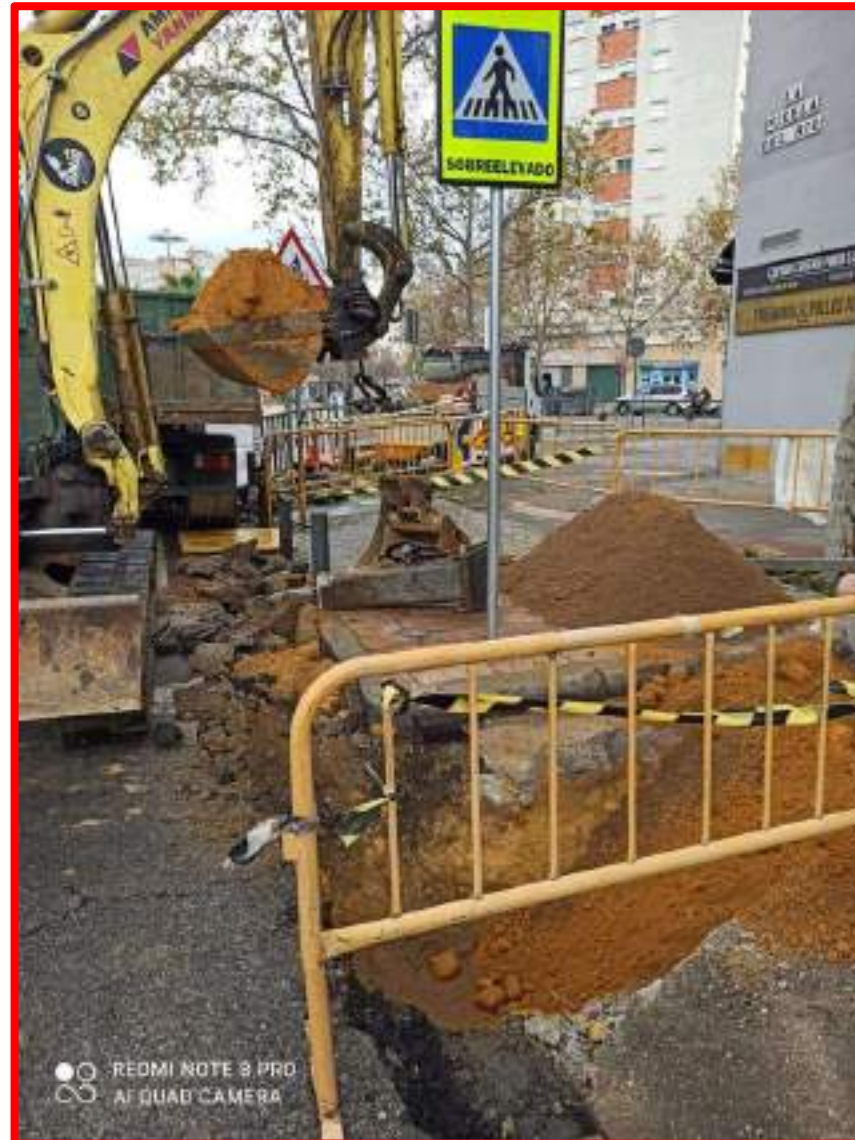
Reparación acerado y calzada C/ Puebla del Río junto Glorieta Forja XXI
