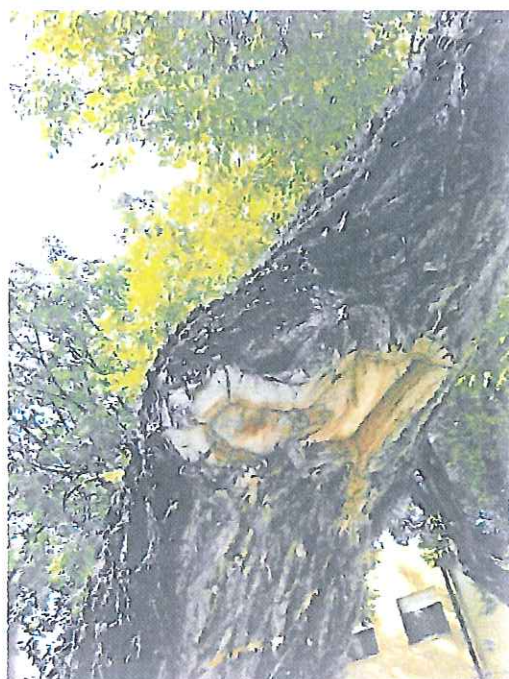
DAÑOS ESTRUCTURALES IMPORTANTES
