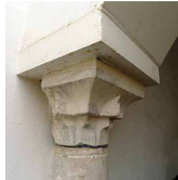
Extremo superior de fuste reaprovechado y capitel de mocárabes de los Baños. © Fernando Amores
