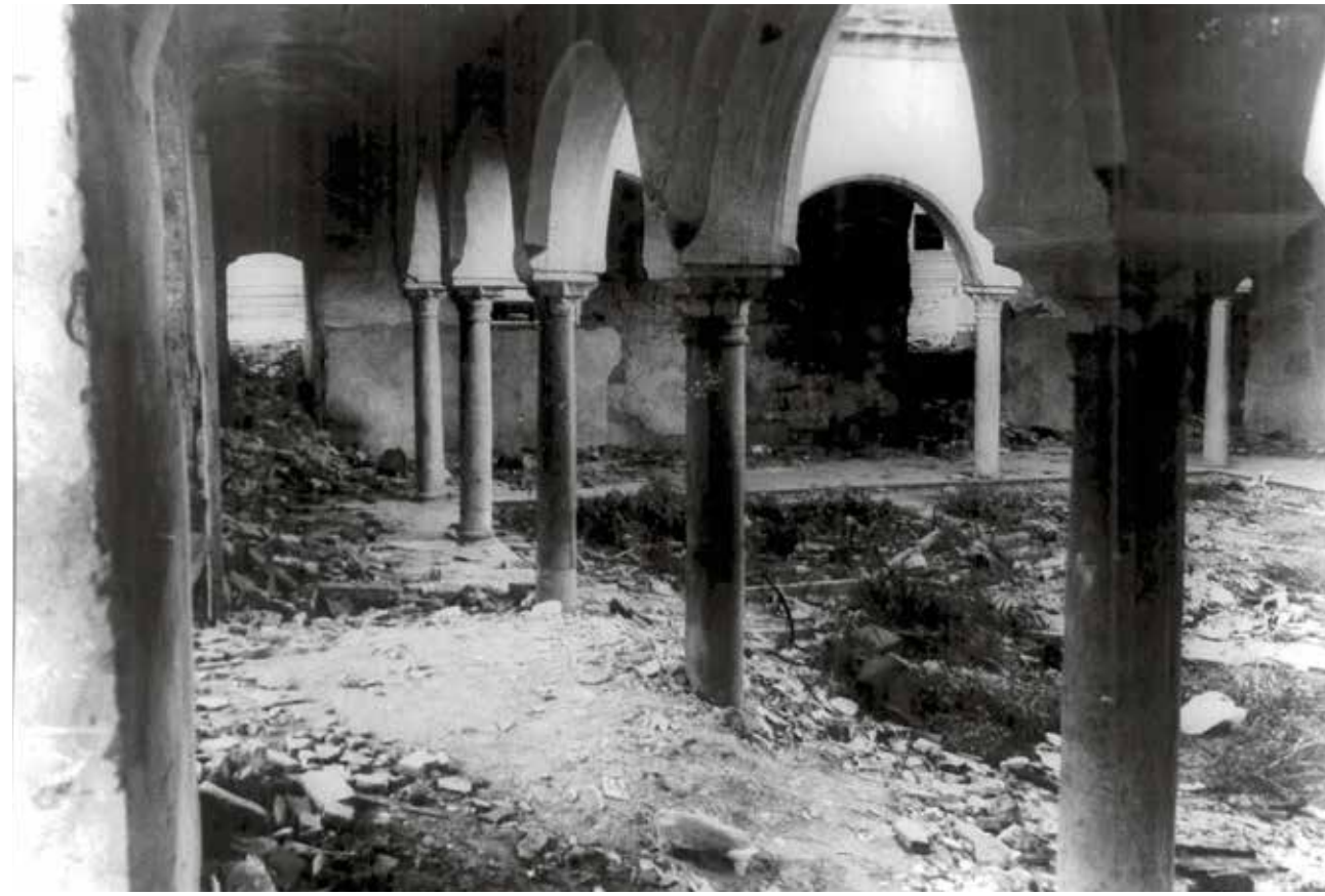
Interior del patio conformado en el siglo XVII para el convento agustino reformando la estructura antigua del baño. Inicios de la década de 1980. © Gerencia de Urbanismo
