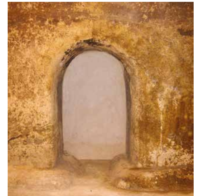
Detalle de uno de los vanos de comunicación internos. © M. Ángel García y M. Ángeles González
