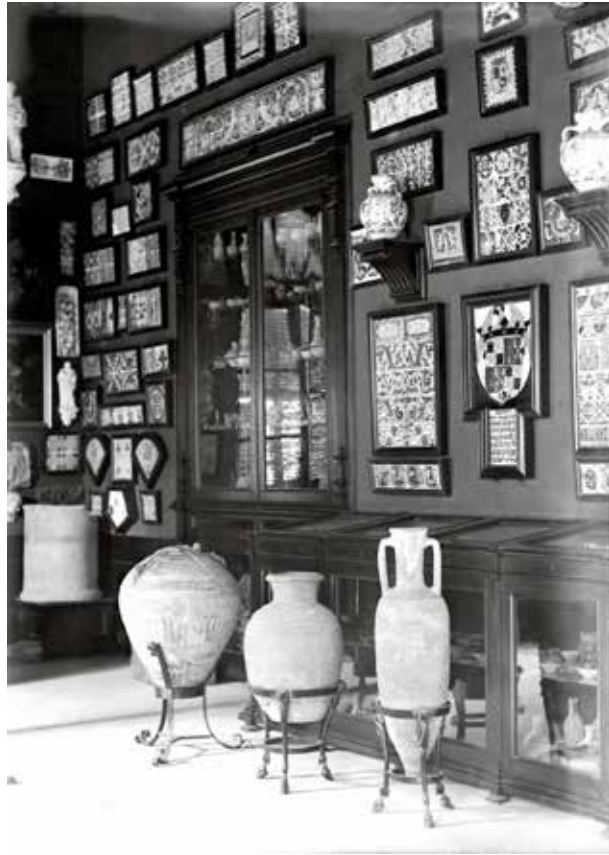
Vista interior del Museo Municipal cuando estaba instalado en la Casa Grande. 1895. © ICAS-SAHP, FMS, archivo Caparró
