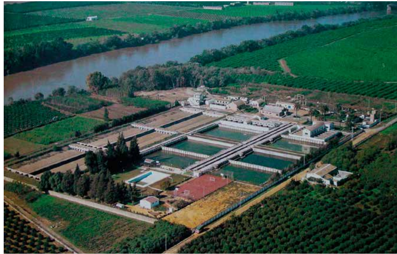
Vista aérea de la antigua Estación de Filtraje de La Algaba. Ingenieros: Mr. Kurriss, Mr. Broderik y Luis Molini, Antonio Izquierdo, Rojas Marcos y el arquitecto Vicente Traver (1913-1923). © EMASESA.
