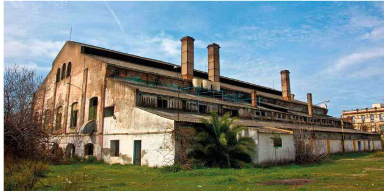
Fábrica de vidrio la Trinidad. Arquitectos: Luís Rodríguez Caso (1900-02), Vicente Traver y Tomás (1924) y Ramón Balbuena (1926). © Julián Sobrino
