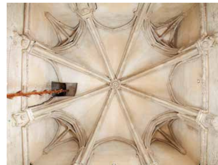
Fig. 3 Detalle de la bóveda de nervios de la torre
