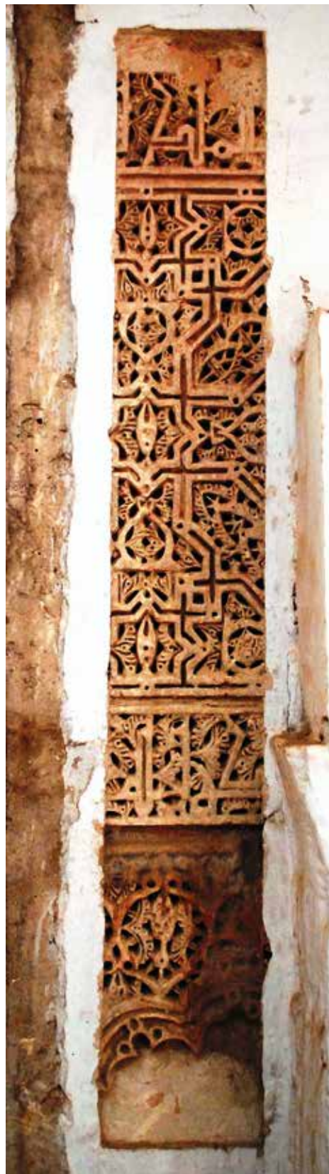
Fig. 1 y 2 Yaserías aparecidas en el interior del convento de Santa Clara, primitivo palacio de don Fadrique
