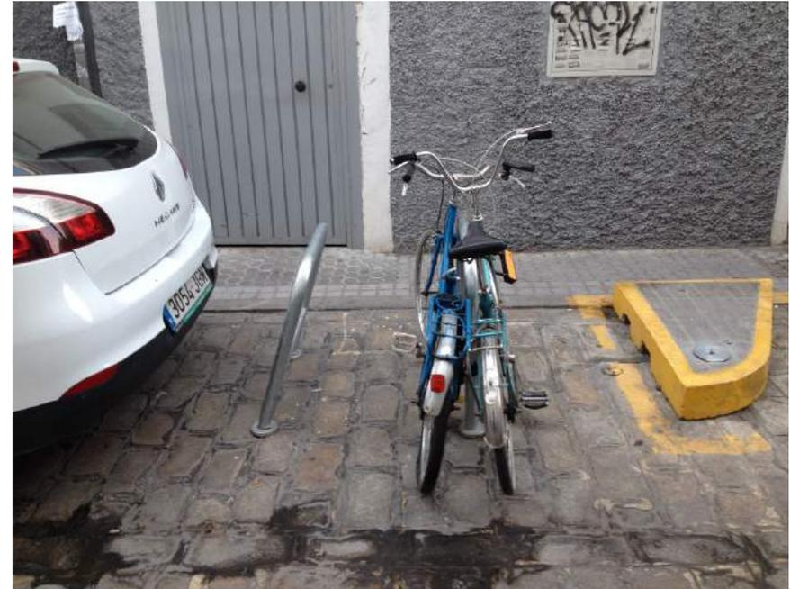
*Daños en un bicicletero instalado en la banda de aparcamiento de coches al no estar físicamente balizado el área del bicicletero.*
