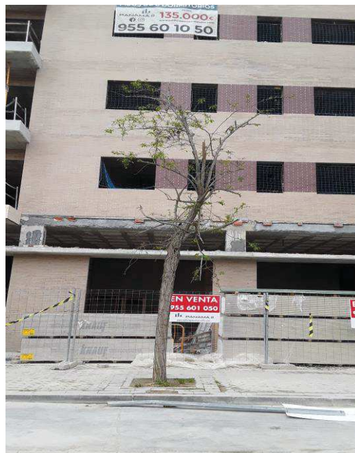
(Fotografía perteneciente a la inspección realizada el 24 de marzo de 2022)
