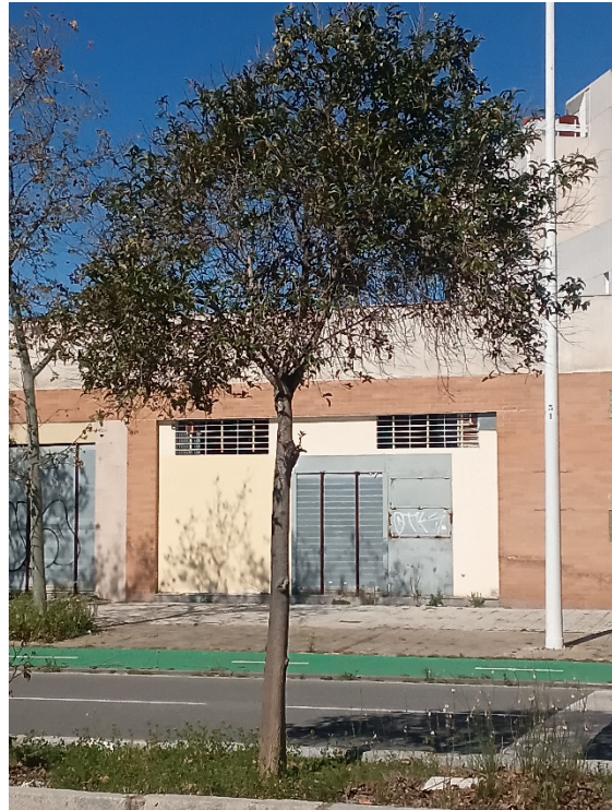
Vista general: árbol desvitalizado, interferencias con vehículos
