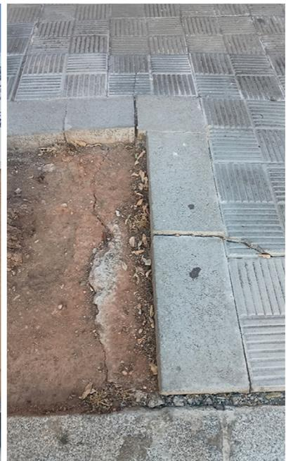
Grietas y abombamiento del pavimento circundante a tensión, y grietas recientes entre el suelo y el alcorque.
