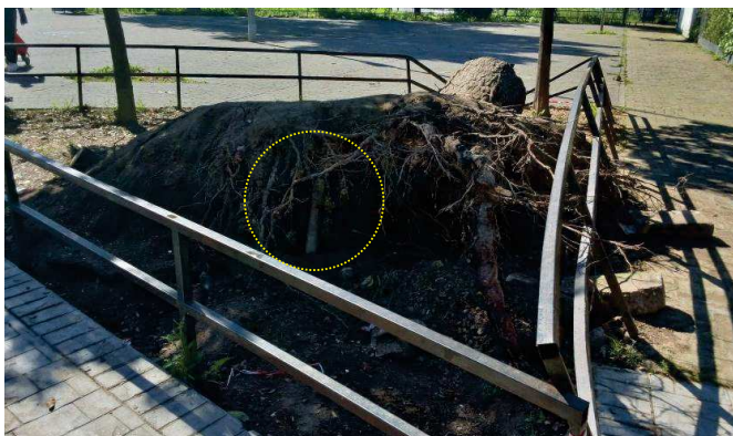
Canalización subterránea (cableado eléctrico)
