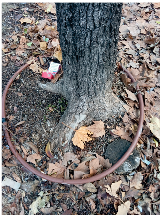
Raíces superficiales. Herida longitudinal por asolamiento desde el cuello hasta la cruz con cámbium disfuncional/madera vista.
