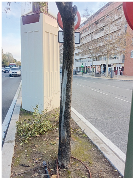
Herida longitudinal por asolanamiento con madera vista/pudrición.
