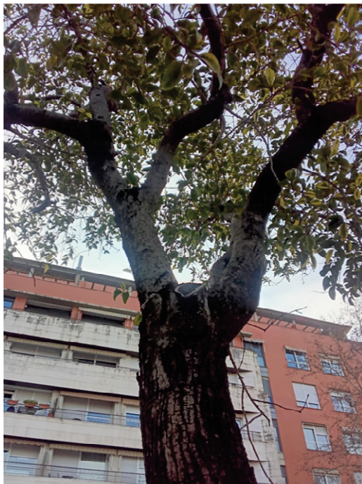
Desvitalización. Heridas de poda tras eliminación de primarias con madera vista/pudrición.
