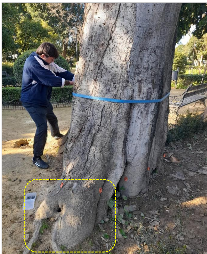
8. En los resultados de la tomografía muestra que solo en una pequeña sección del contrafuerte se aprecia madera residual
