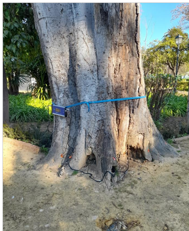
7. Vista de la madera degradada en los contrafuertes en la zona de tensión
