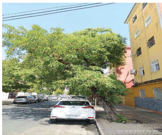
(Foto de la inspección realizada el 05/08/2025)
