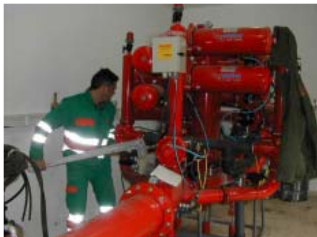
Montaje del equipo de filtrado
