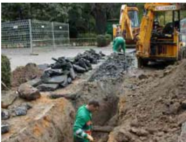
Apertura de avenidas del Parque en el zanjeado de la red primaria
