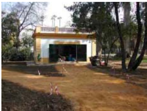
Estado final de la caseta de bombeo
