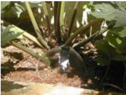
Funcionamiento de los borboteadores usados para la inundación de parterres
