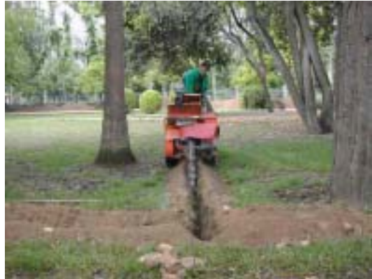
Detalle de la operación de zanjeado
