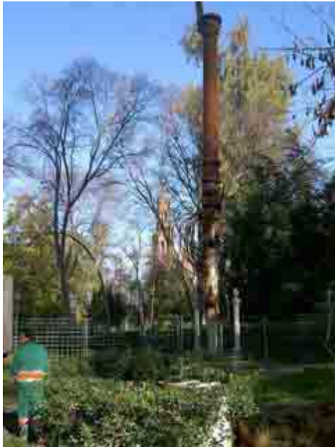
Retirada de la antigua bomba preexistente en el Pozo de Dante
