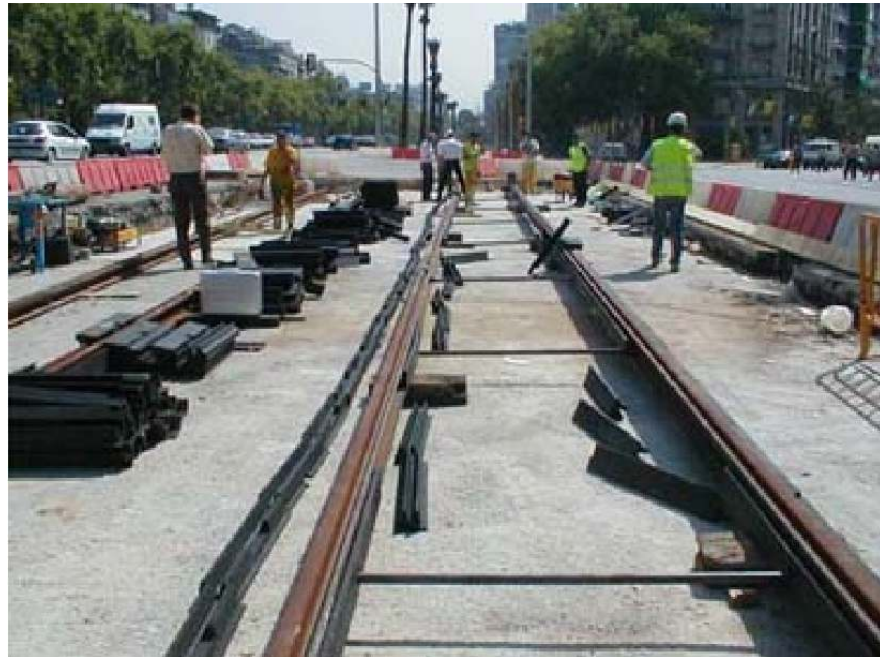
Figura 9. Ajuste del ancho de vía mediante riostras
