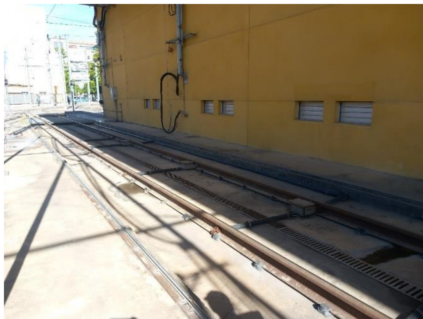
Fotografía 101.- Vía de lavado. Vista cerramiento nave taller
