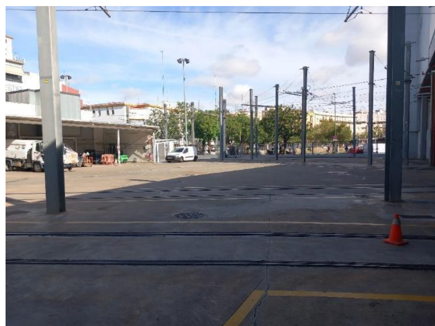
Fotografía 6.- Espacio entre la marquesina y las puertas de los talleres y cocheras (vista norte)
