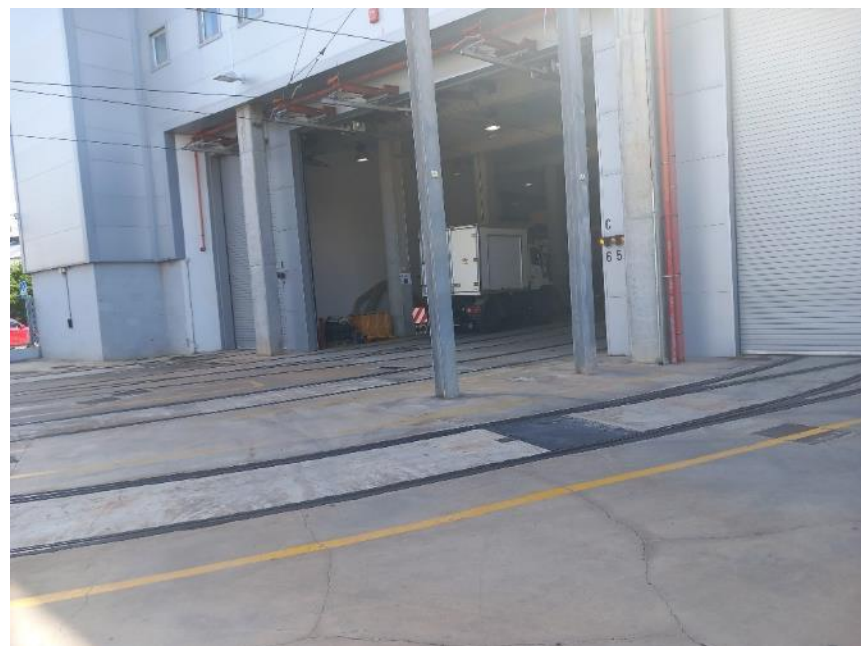
Fotografía 21.- Acceso a cocheras. Máquina bivial de mantenimiento
