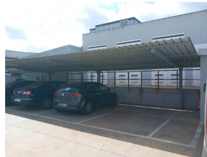
Fotografía 43.- Marquesina para aparcamiento de vehículos, junto al edificio de la SET
