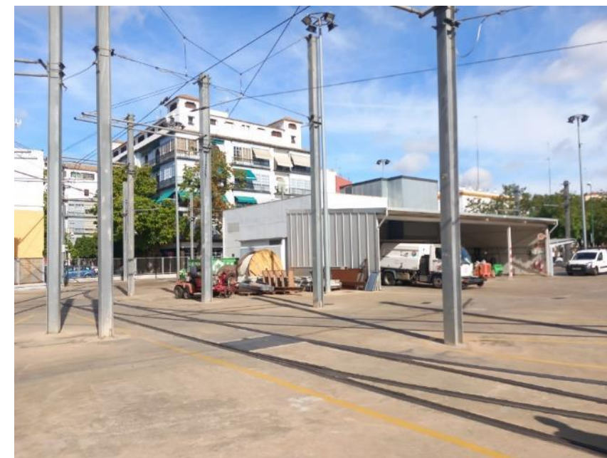
Fotografía 3.- Vista marquesina en la trasera del edificio de la SET (vista noroeste parcela)
