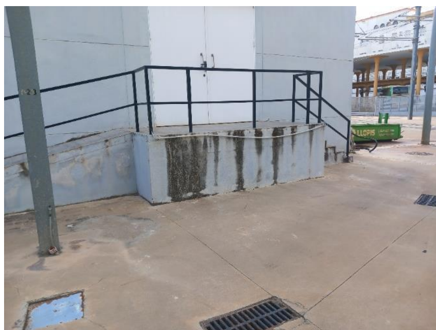
Fotografía 38.- Vista de la puerta principal del edificio de la SET
