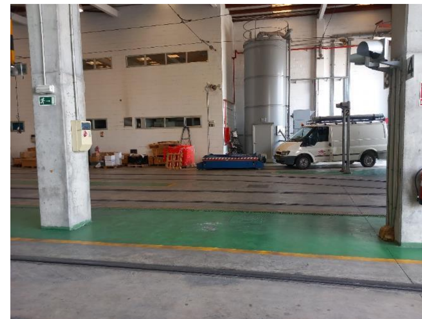
Fotografía 47.- Vista interior cocheras. Silo de arena al fondo
