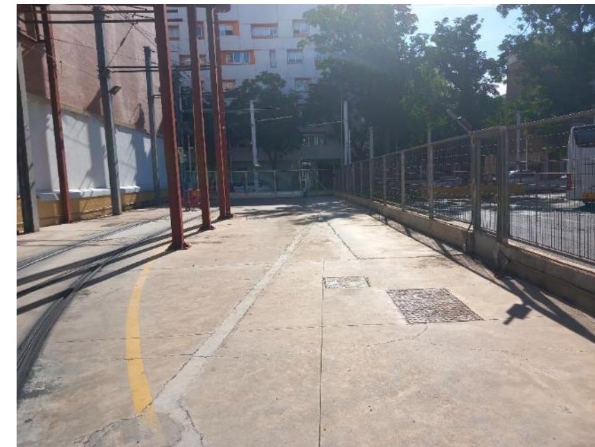
Fotografía 95.- Zona exterior futuro acceso a nueva playa de vías aparcamiento exterior
