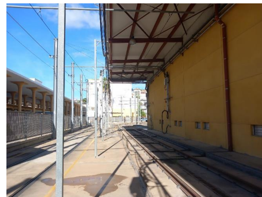
Fotografía 100.- Vía de lavado. Vista oeste
