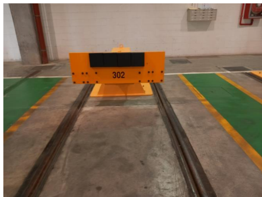
Fotografía 74.- Topera. Interior cocheras
