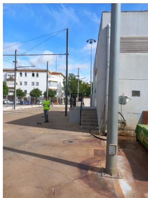
Fotografía 30.- Acceso a la escalera del edificio de la SET. Vista norte
