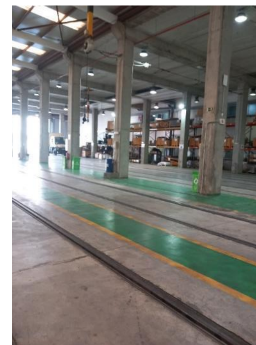
Fotografía 76.- Viarios interior cocheras
