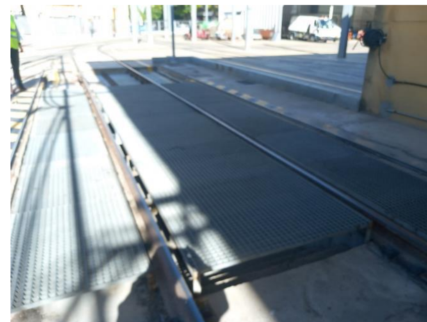
Fotografía 104.- Foso de inspección en vía de acceso
