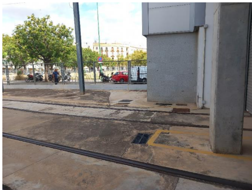
Fotografía 45.- Viarios de acceso a cocheras. Vista norte
