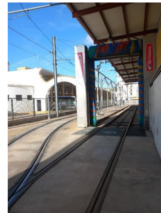
Fotografía 91.- Viarios de acceso a zona de lavado
