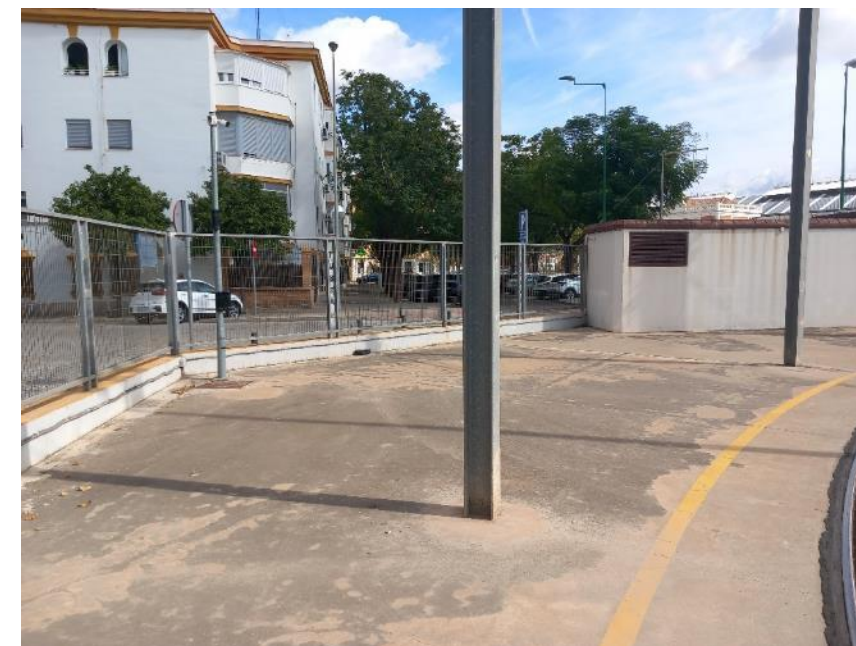
Fotografía 39.- Zona exterior talleres y cocheras. Vista casera ENDESA acometida MT
