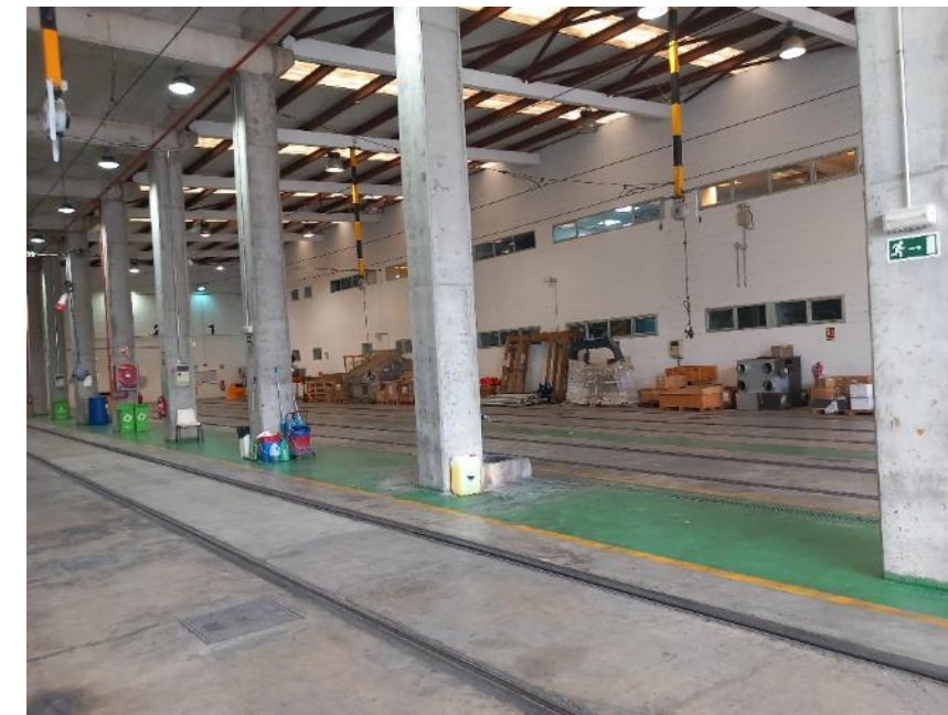
Fotografía 51.- Vista interior de las vías (1-4) en el interior de la nave cochera
