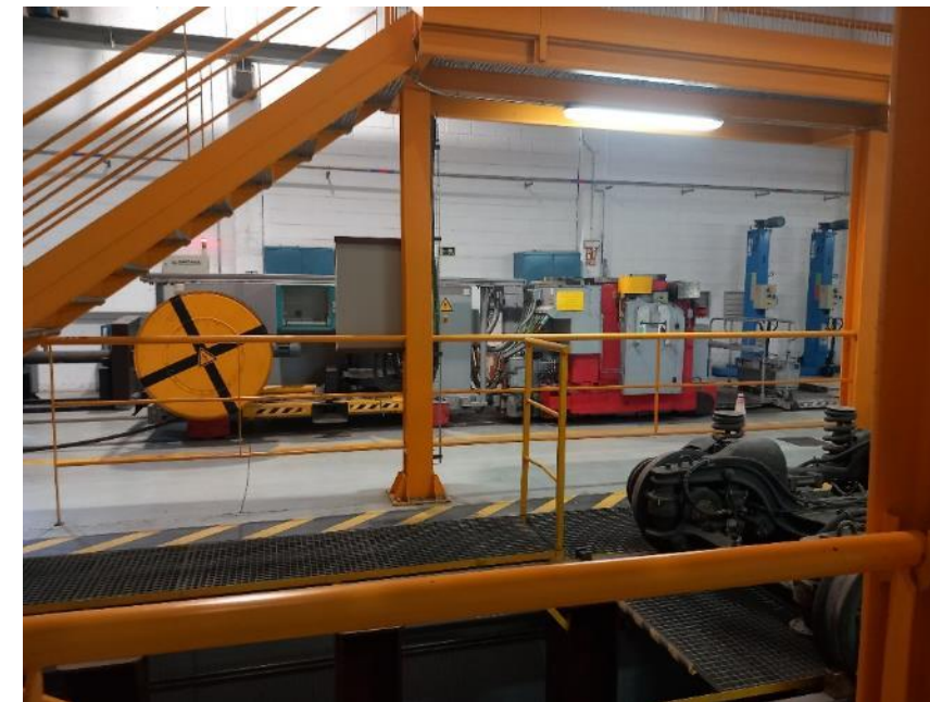
Fotografía 79.- Vista de pasarela de inspección. Interior talleres
