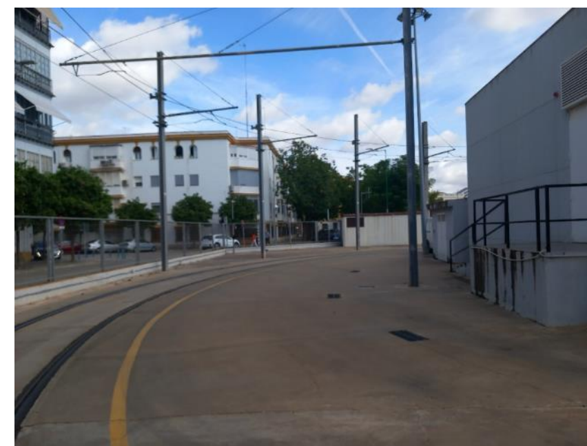
Fotografía 36.- Viario exterior frontal oeste del edificio de la SET. Vista norte
