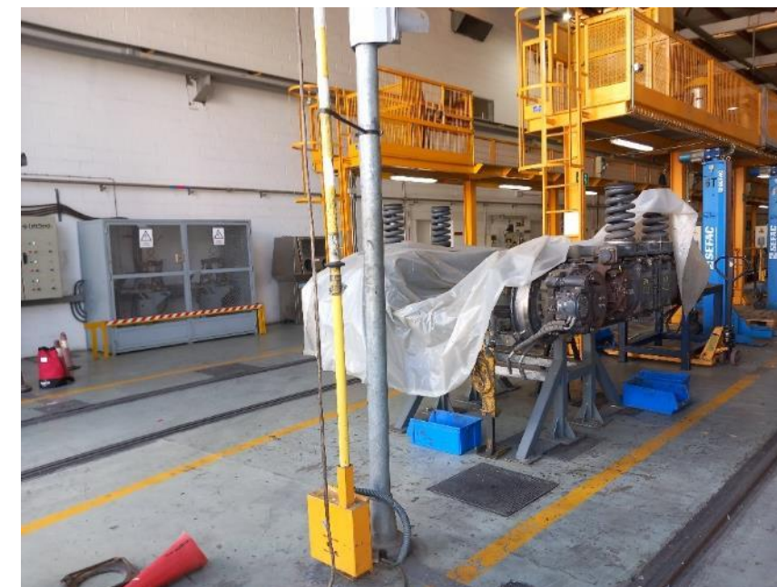
Fotografía 7.- Vista interior de vías y pasarela inspección talleres. Maquinaria bogies
