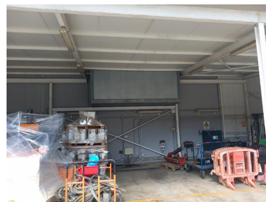
Fotografía 24.- Uso como almacén de la marquesina exterior
