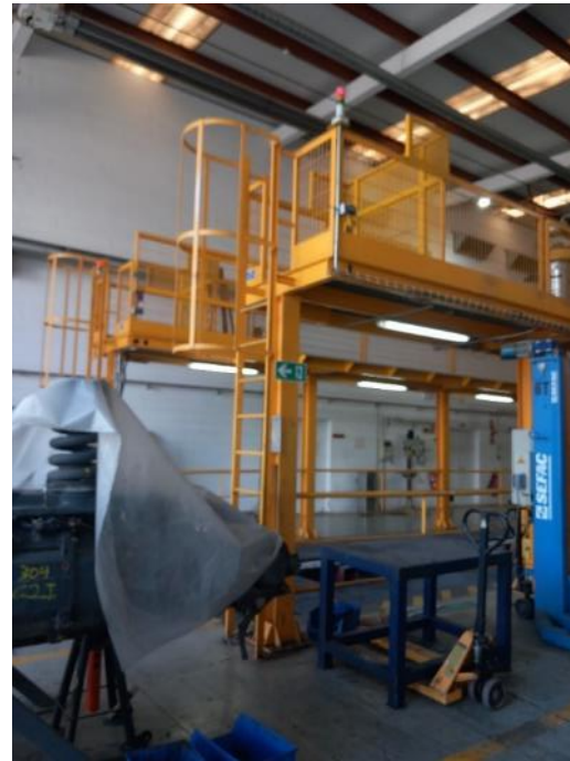
Fotografía 9.- Vista pasarela de inspección,. Talleres y maquinaria bogies
