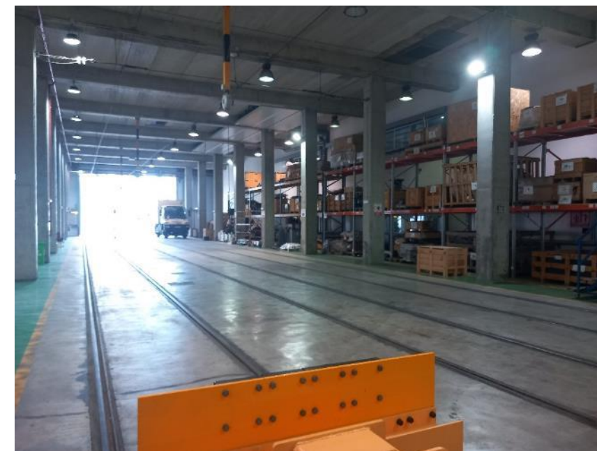
Fotografía 71.- Vías 4-6 interior cocheras. Vista hacia el acceso
