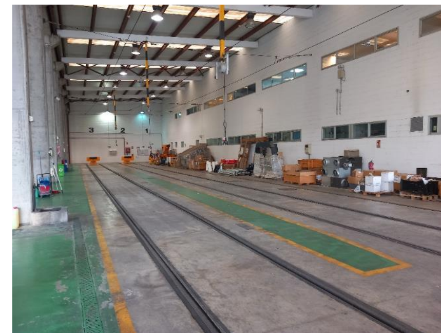
Fotografía 52.- Vista interior de la vía 1 empleada como almacén en el interior de la nave cochera
