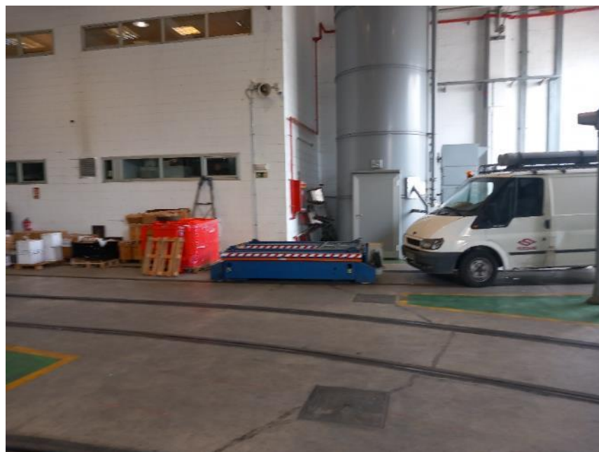
Fotografía 53.- Vista interior de la vía 1 empleada como almacén y silo de arena en el interior de la nave cochera
