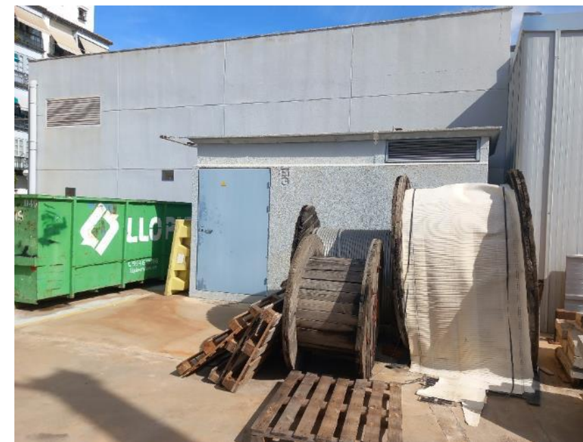
Fotografía 27.- Zona de almacenaje de residuos junto al edificio prefabricado de los seccionadores de catenaria
