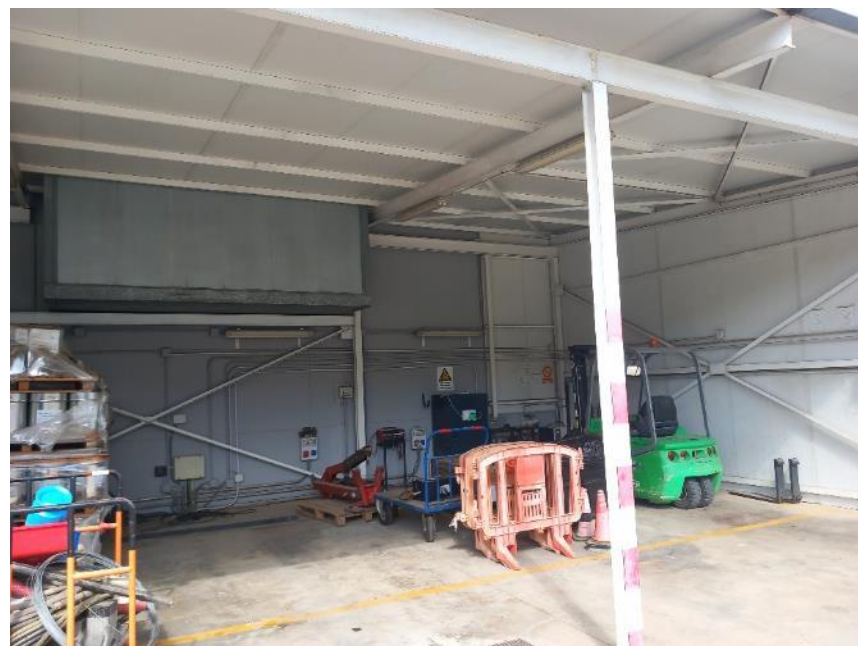
Fotografía 25.- Uso como almacén de la marquesina exterior. Carretilla elevadora eléctrica
