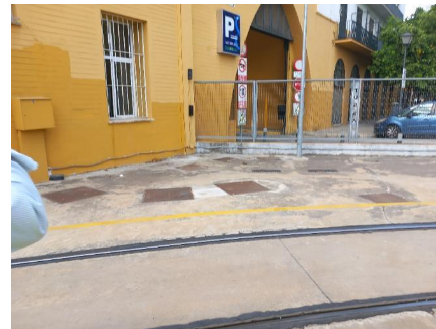
Fotografía 35.- Arquetas de la EBAR (enterrada) situada junto al acceso exterior de la estación de autobuses
