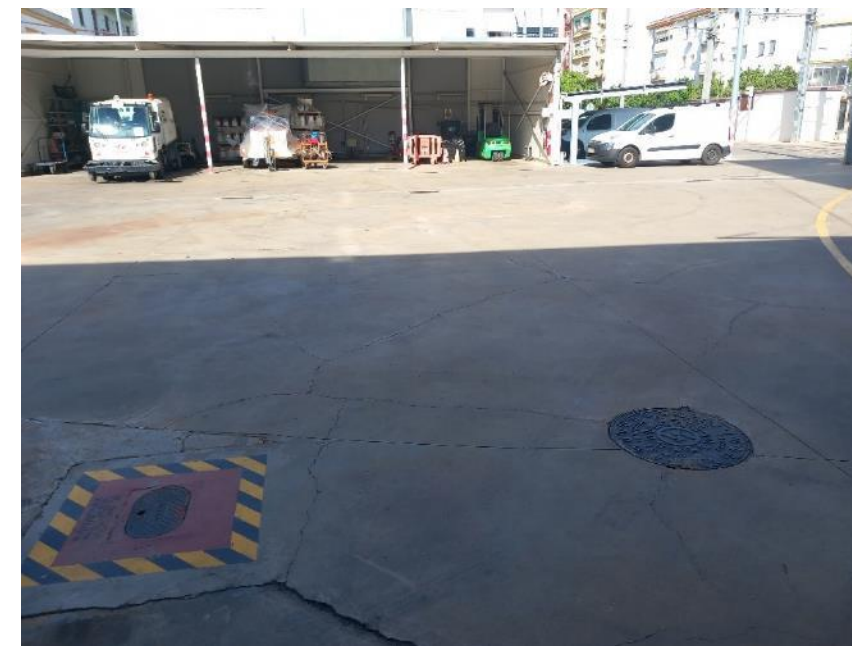
Fotografía 19.- Arqueta PCI, al fondo marquesinas y puerta de acceso exterior vehículos
