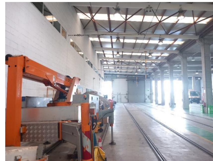
Fotografía 75.- Viarios interior cocheras. Vista hacia el acceso
