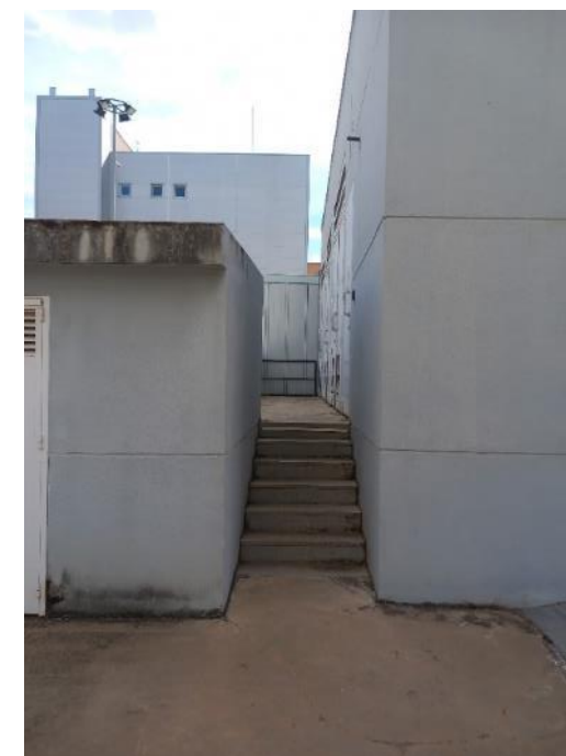
Fotografía 40.- Vista de la puerta lateral del edificio de la SET y habitáculos de los transformadores
