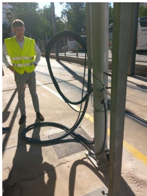
Fotografía 97.- Máquina de suministro de arena zona exterior
