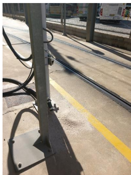
Fotografía 98.- Máquina de suministro de arena zona exterior
