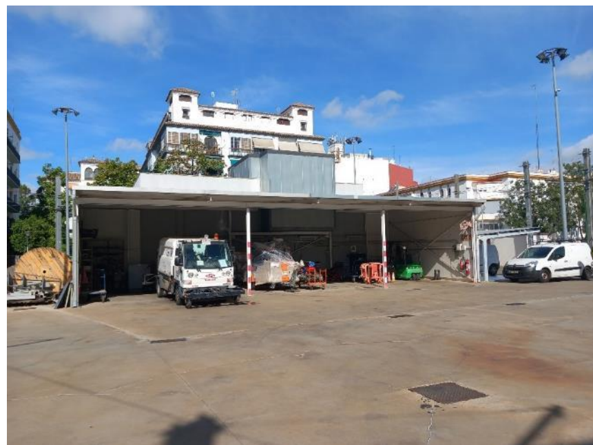
Fotografía 17.- Marquesina trasera del edificio SET y lateral para aparcamiento de vehículos
