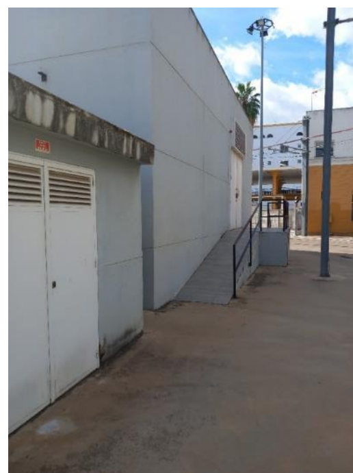
Fotografía 42.- Zona exterior edificio de la SET. Vista sur
