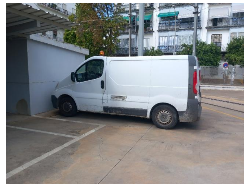
Fotografía 44.- Zona exterior edificio de la SET y marquesina. Vista oeste
