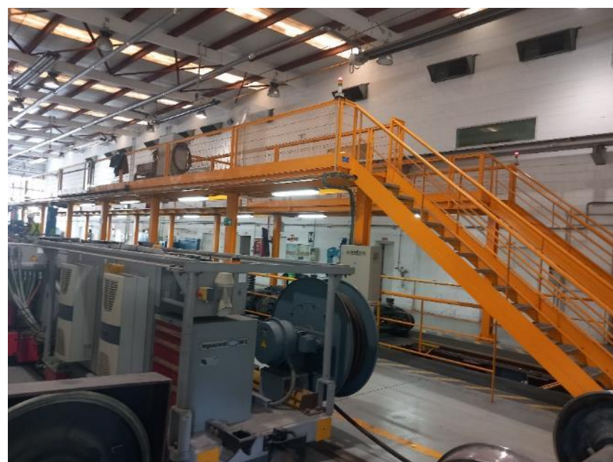
Fotografía 90.- Maquinaria y pasarela al fondo. Vista interior talleres
