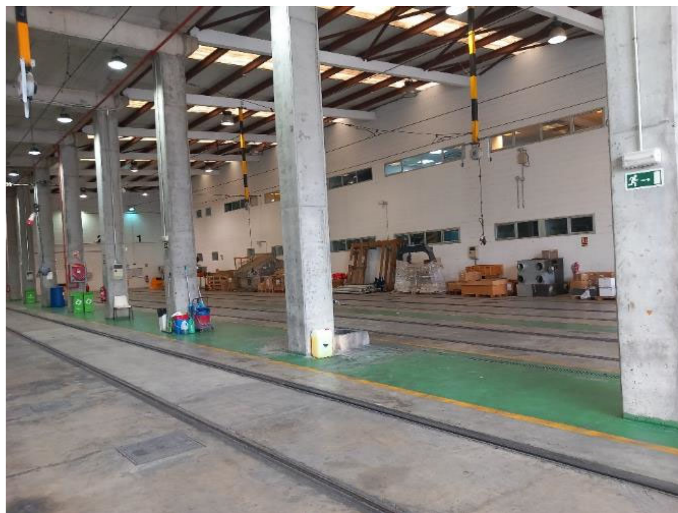
Vista del espacio propuesto para la implantación de la nueva pasarela de inspección de techos en la nave de cocheras
