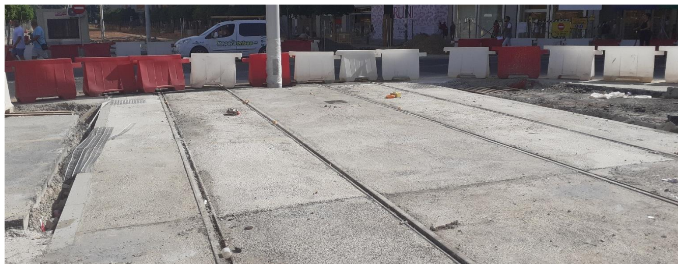
Detalle terminación de plataforma con hormigón
