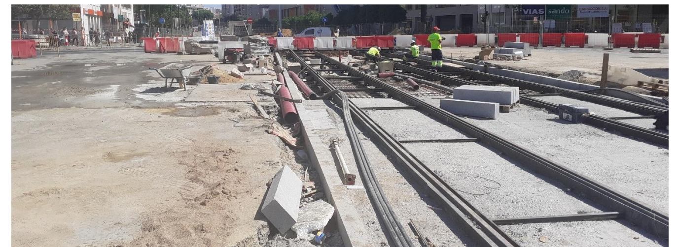
Hormigonado de la vía en placa
