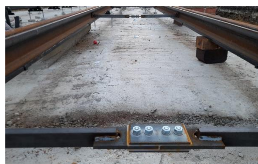
Montaje de riestras aislantes en los puntos donde se requiera aislamiento entre carriles
