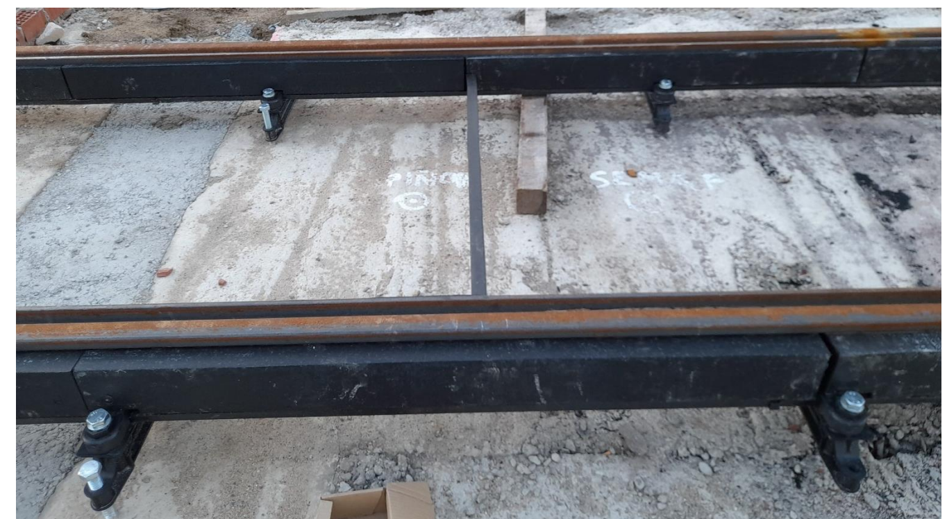
Instalación de los soportes de fijación
