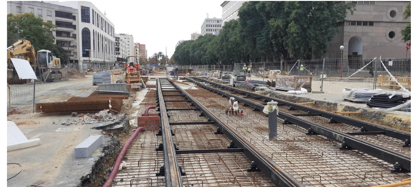
Montaje armadura de la vía en placa
