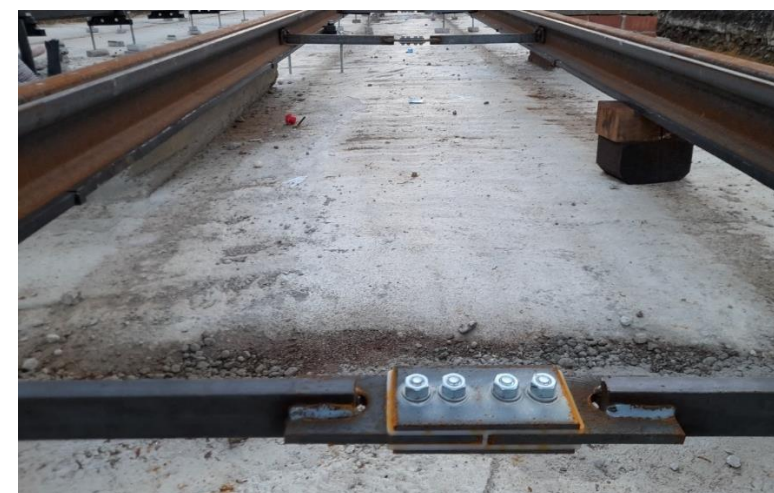
Montaje de riostras aislantes en los puntos donde se requiera aislamiento entre carriles
