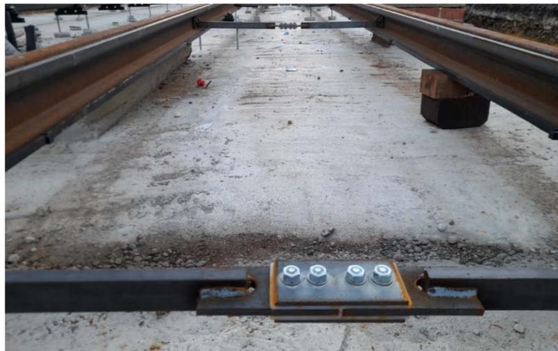
Figura 8. Montaje de riostras aislantes en los puntos donde se requiera aislamiento entre carriles
